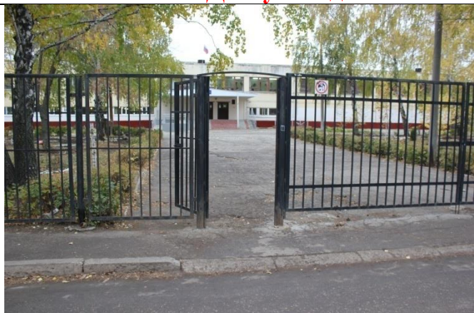
Отсутствие бордюра при входе на территорию школы
